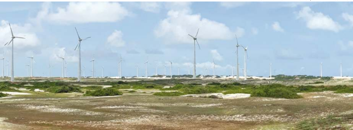
Parque Eólico de Rio do Fogo (RN)
