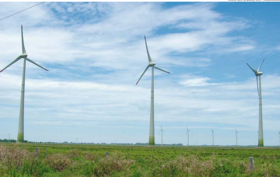
Cata-ventos de energia eólica em Osório, no Rio Grande do Sul.
